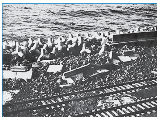
Рис. 1. Разрушенное бетонное берегоукрепление на станции Холмск-сортировочная после штормового нагона в ноябре 1990 г. (Сахалинская железная дорога)
