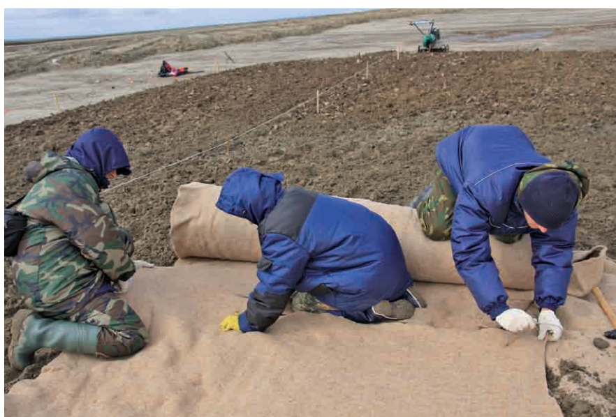
Рис. 6. Выполнение работ по укладке биомата на пилотном участке рекультивации № 1
