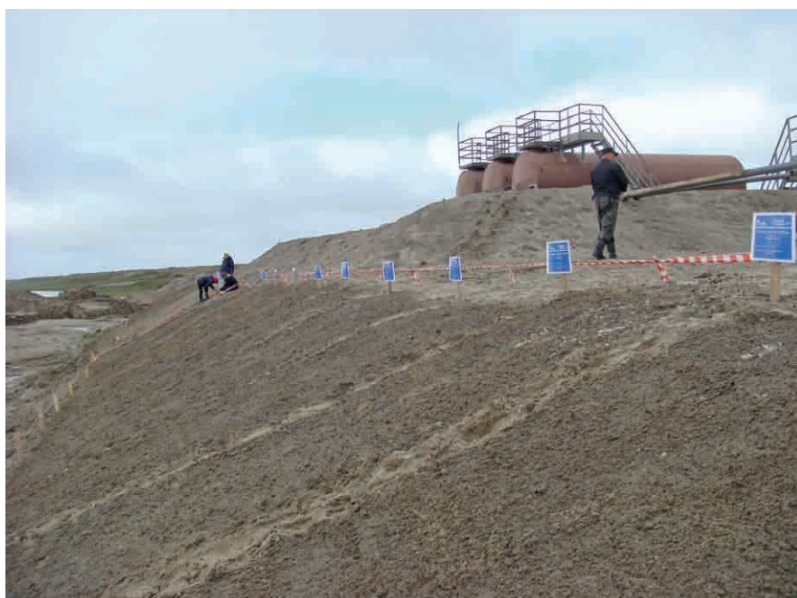
Рис. 5. Выполнение работ по подбору эффективной технологии рекультивации на эрозионно-опасном участке песчаного склона карьера № 3
